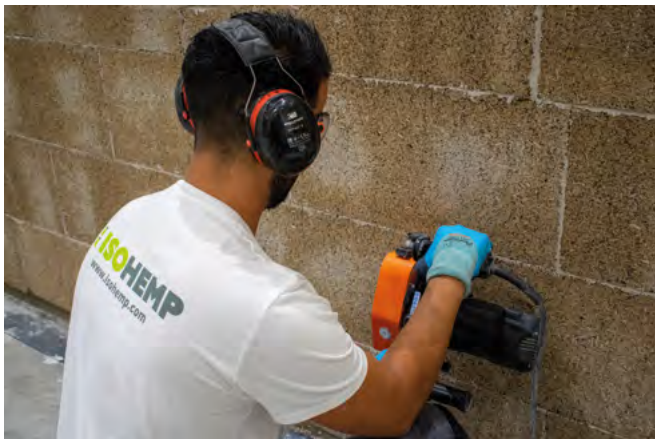
1 Procédez au rainurage à l'aide d'une rainureuse.
