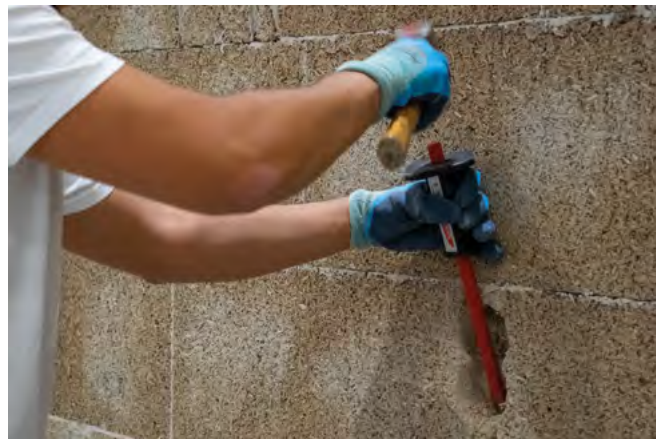
2 Finalisez l'ouverture manuellement.
