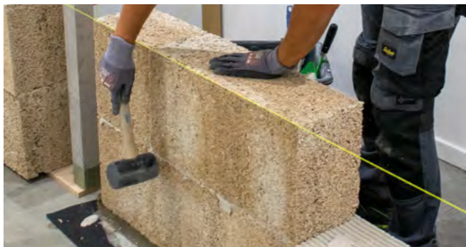
9 Ajustez au maillet et vérifiez les niveaux.
