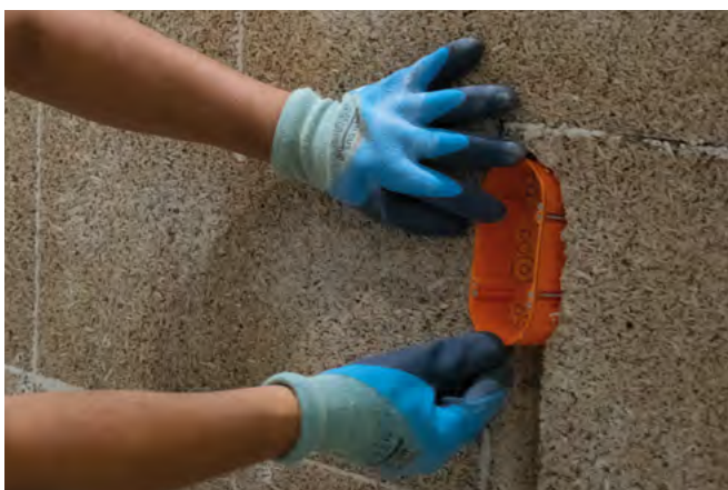
3 Fixez boîtiers et gaines électriques.
