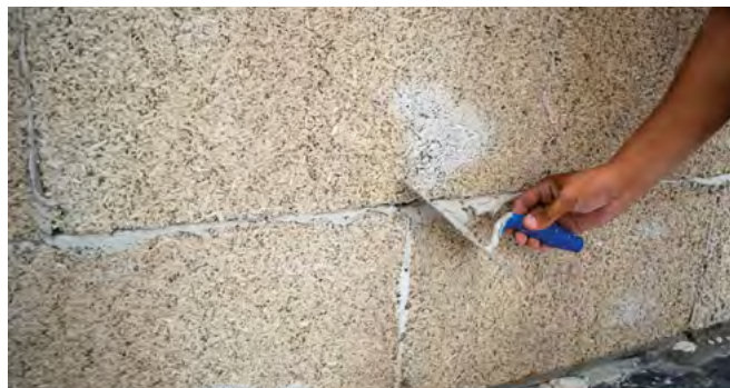
10 Enlevez le surplus de colle à la truelle pour éviter des joints fantômes.
