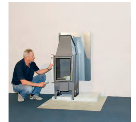
Orienter l'insert de cheminée à l'aide du niveau à bulle
