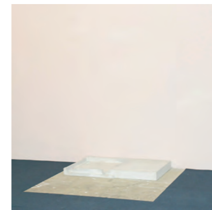
Fixer et marquer l'emplacement d'installation
