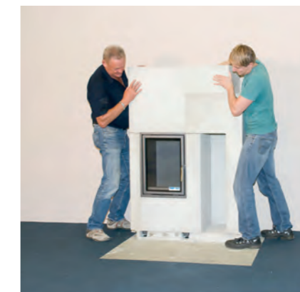
Assembler les éléments d'habillage un à un et les coller
