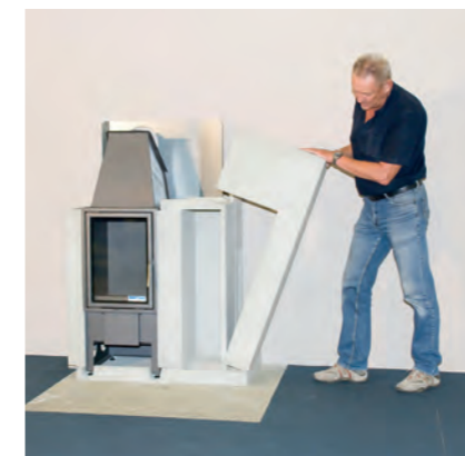
Assembler les éléments d'habillage un à un et les coller
