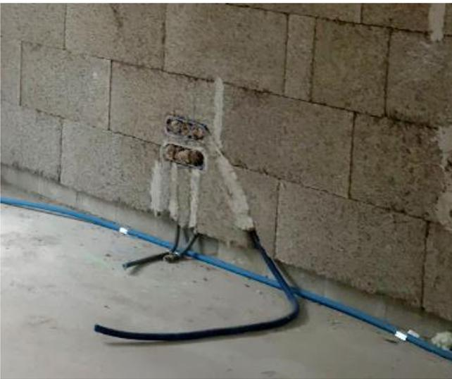
La réalisation des saignées pour les réseaux (électricité, eau...) se fait à l'aide d'une rainureuse et d'une scie cloche adaptée.
