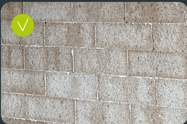
Bon traitement des joints
